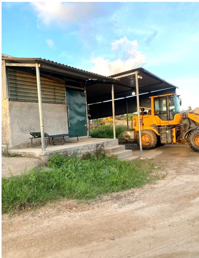
Nhà nghỉ CN trong khu vực Dự án
