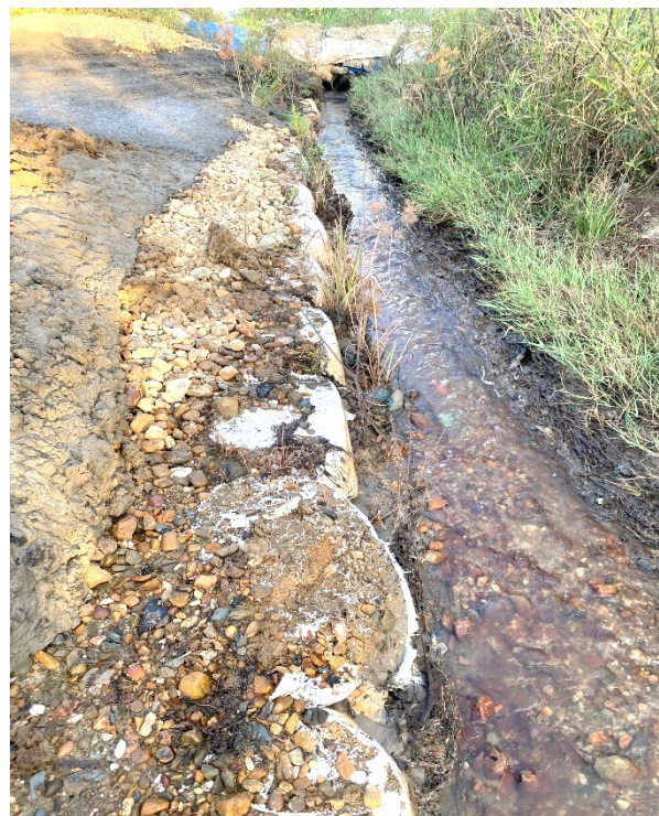
Mương thoát nước hiện trạng
